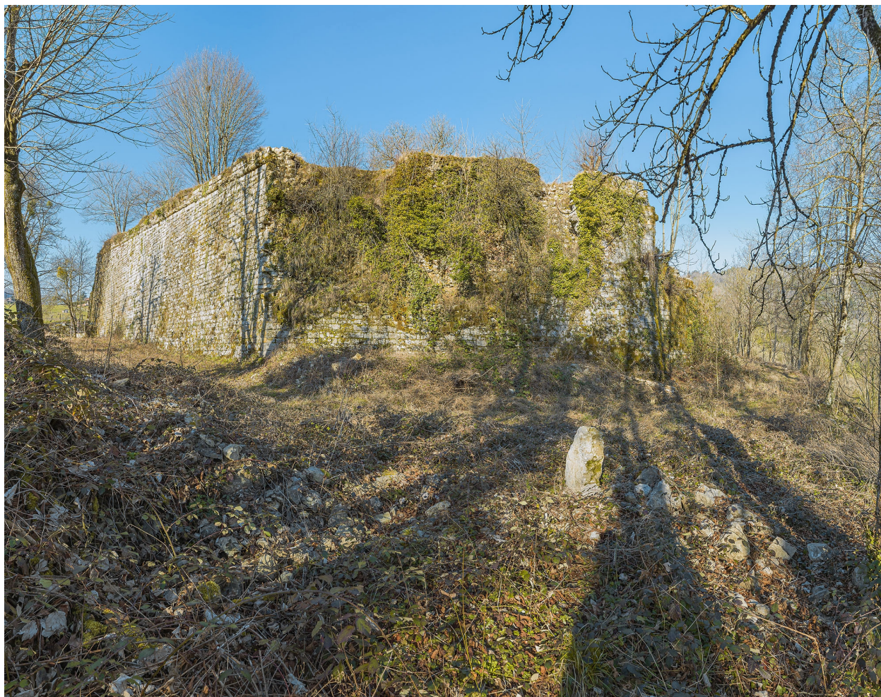
Vue depuis le nord.
