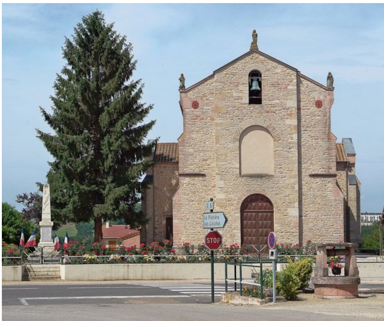
Vue d'ensemble de la façade.
