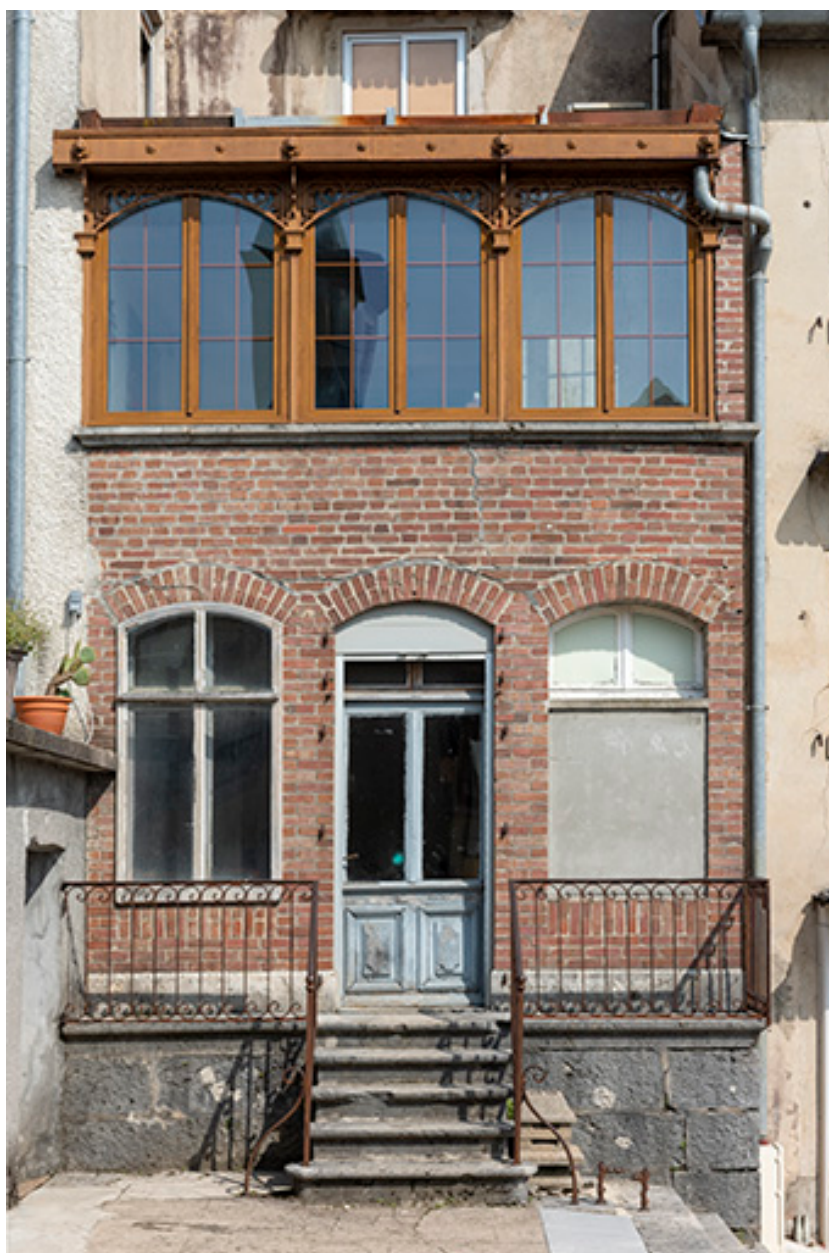
Magasin industriel rue du Chêne, de face.
