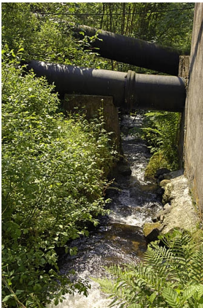
Arrivée des conduites forcées.
