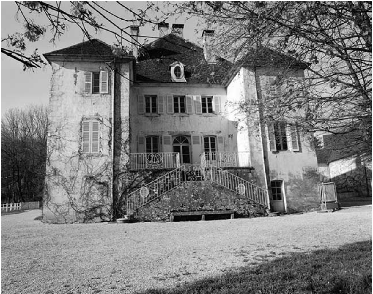
Logis : façade nord.
