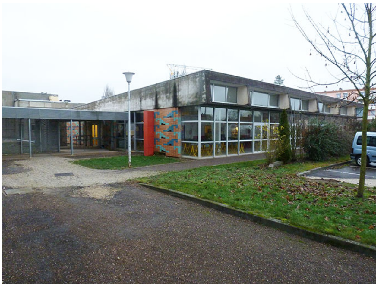
Angle sud-ouest de la cantine (en 2012)
