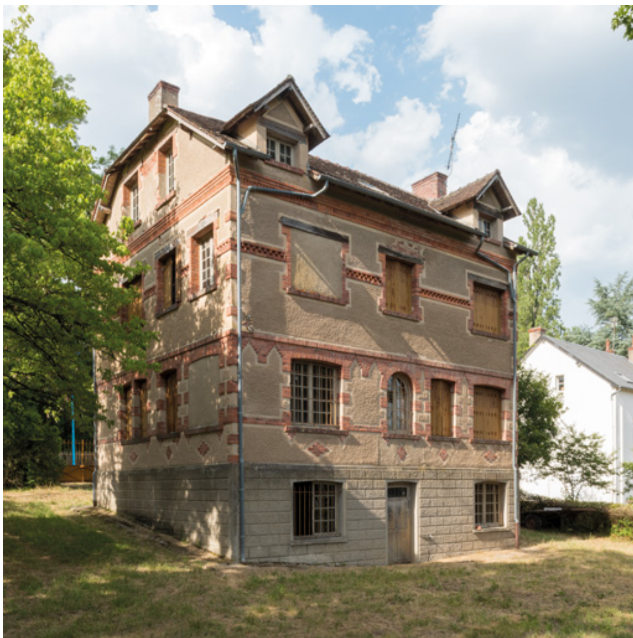
Façade postérieure, vue depuis le sud-ouest.
