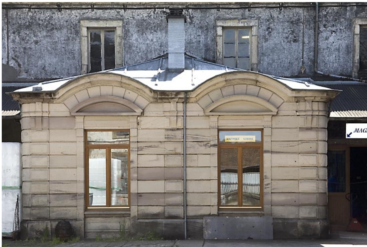
Bureaux. Mur sud de la cour.
