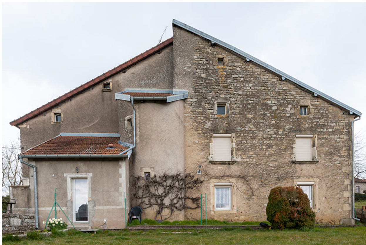
détail sur la maison avec tourelle.
