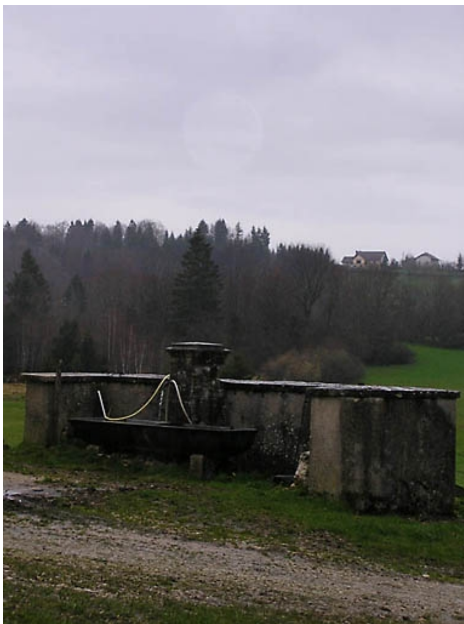
Vue de la fontaine abreuvoir.
