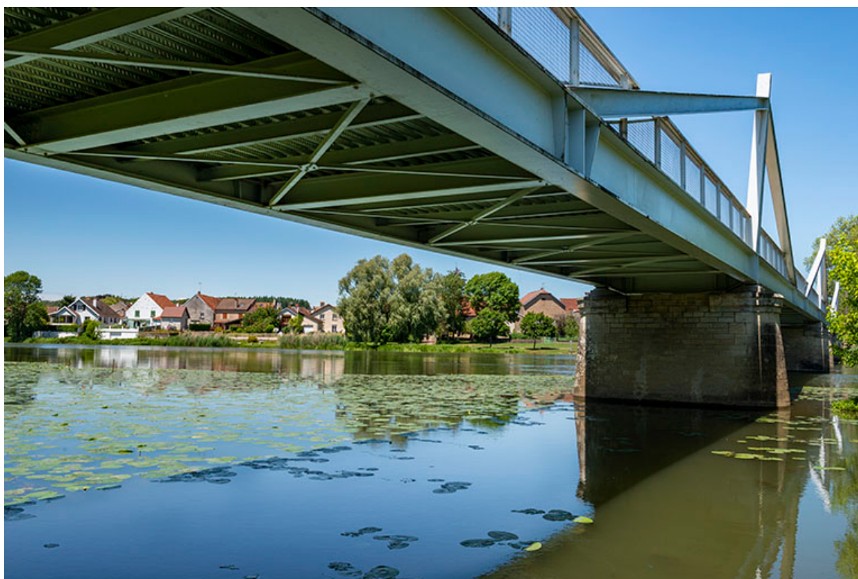
Tablier métallique du pont.
