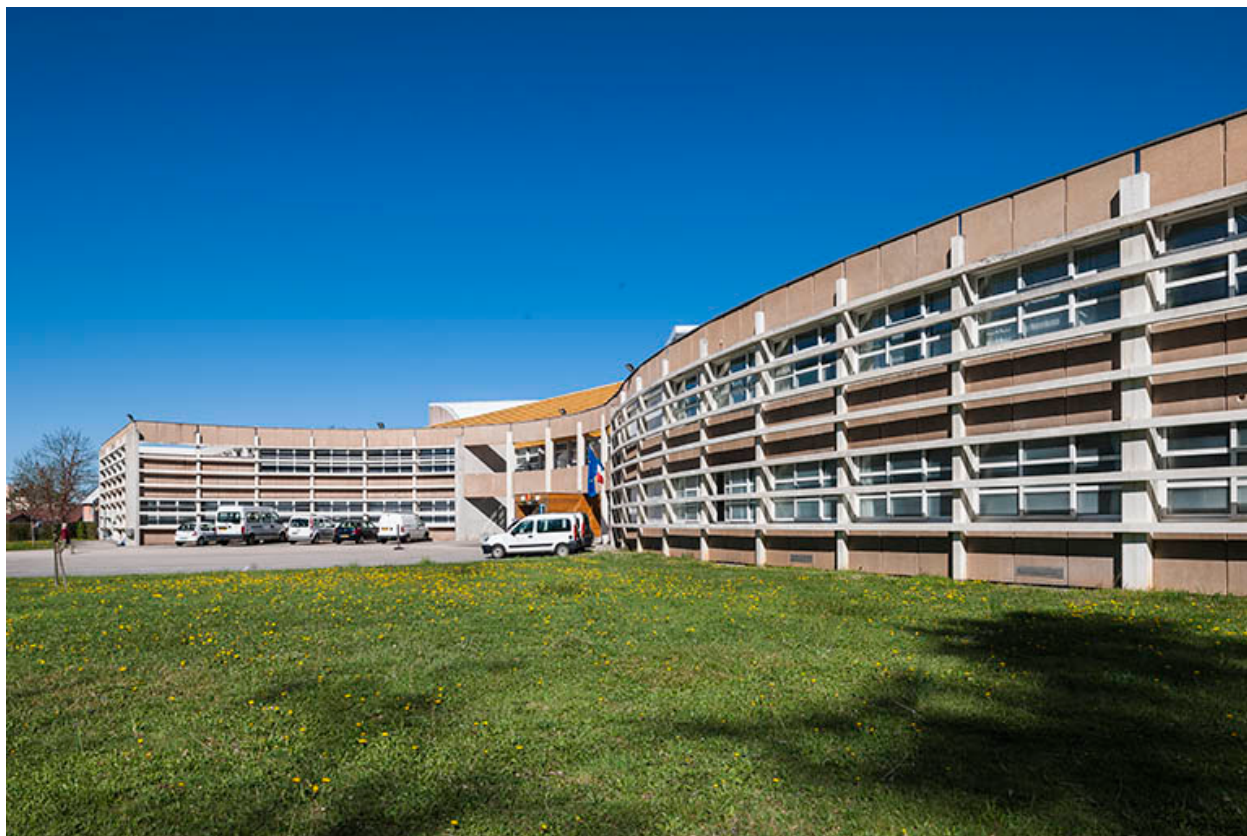
Aministration -restauration : façades antérieures.
