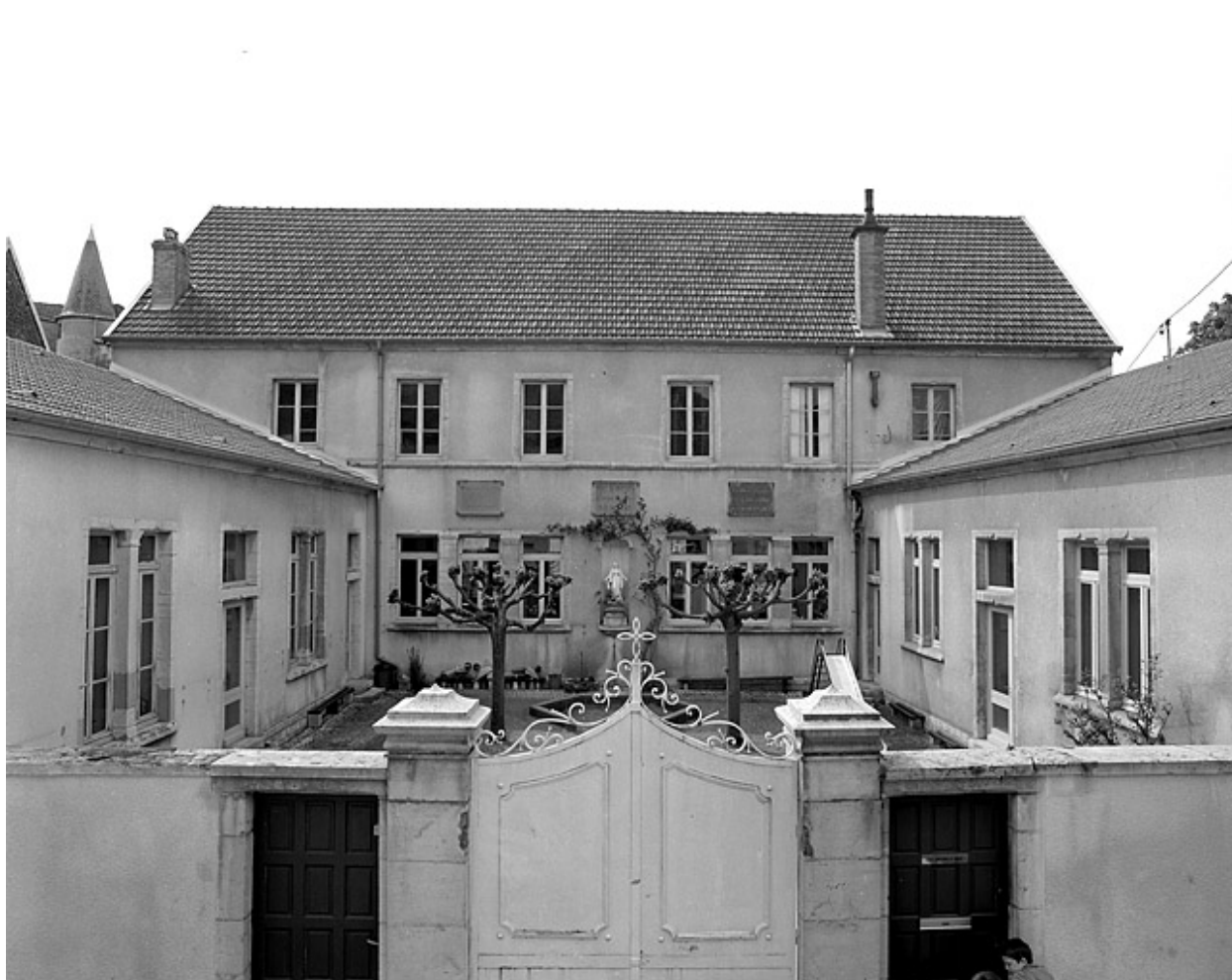
Vue d'ensemble, de face.
