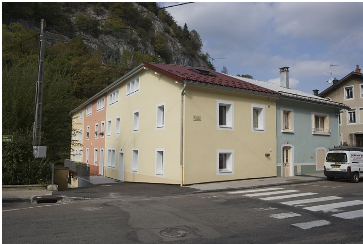
Vue de trois quarts, après restauration.
