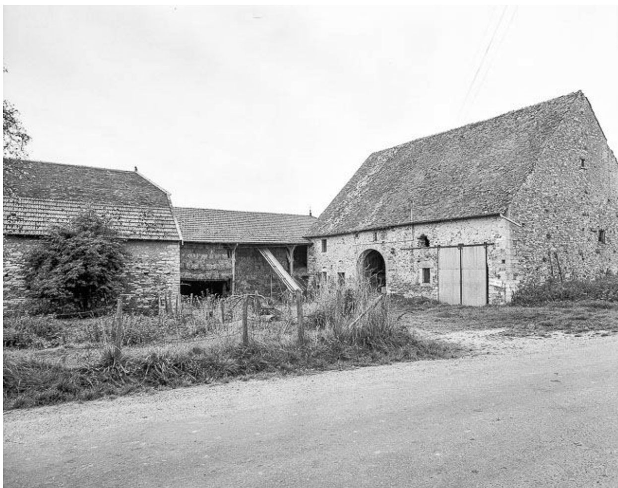
Façades sur cour.
