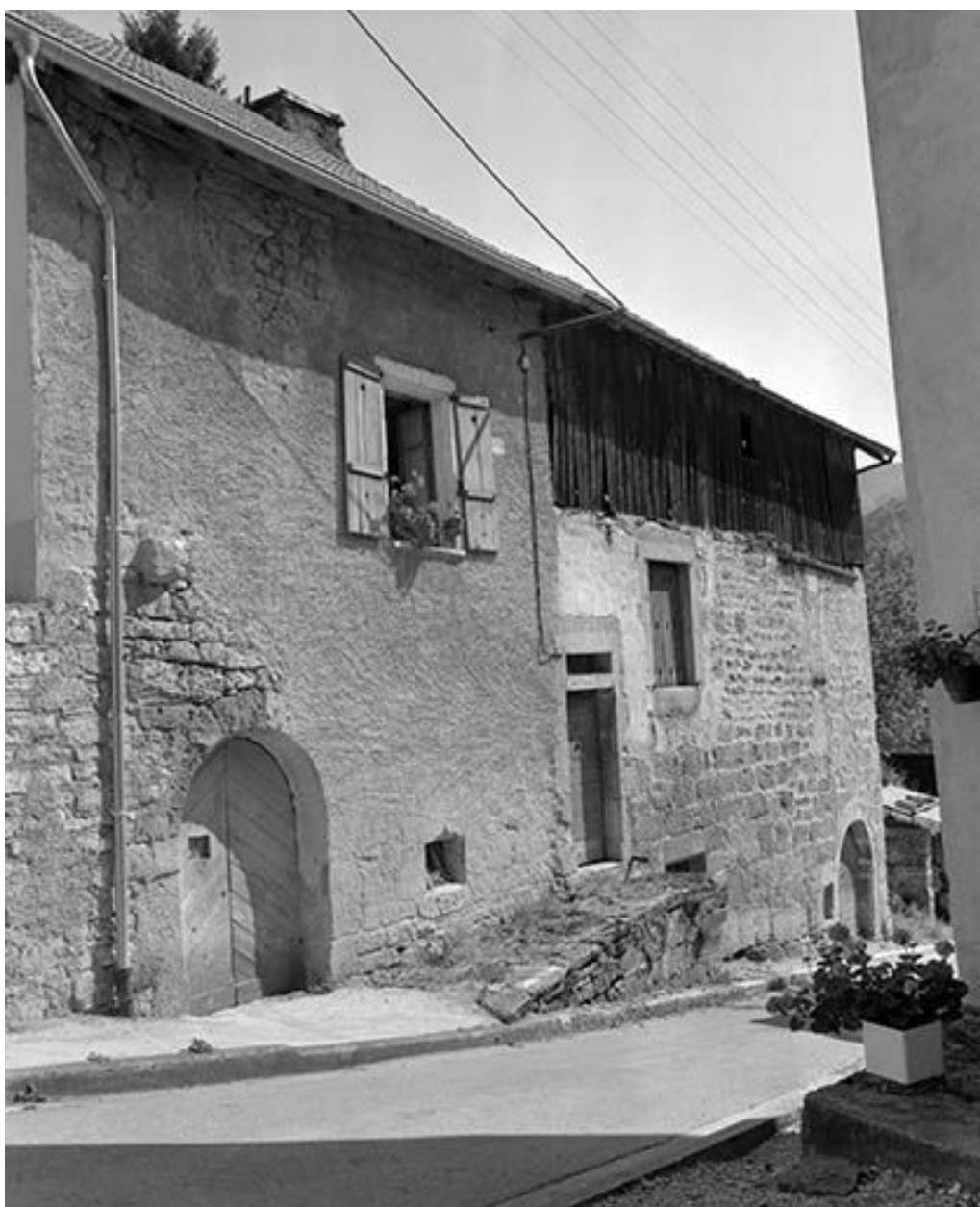
Maison située rue de Jaubourg, cadastrée 1971 AC 66.
