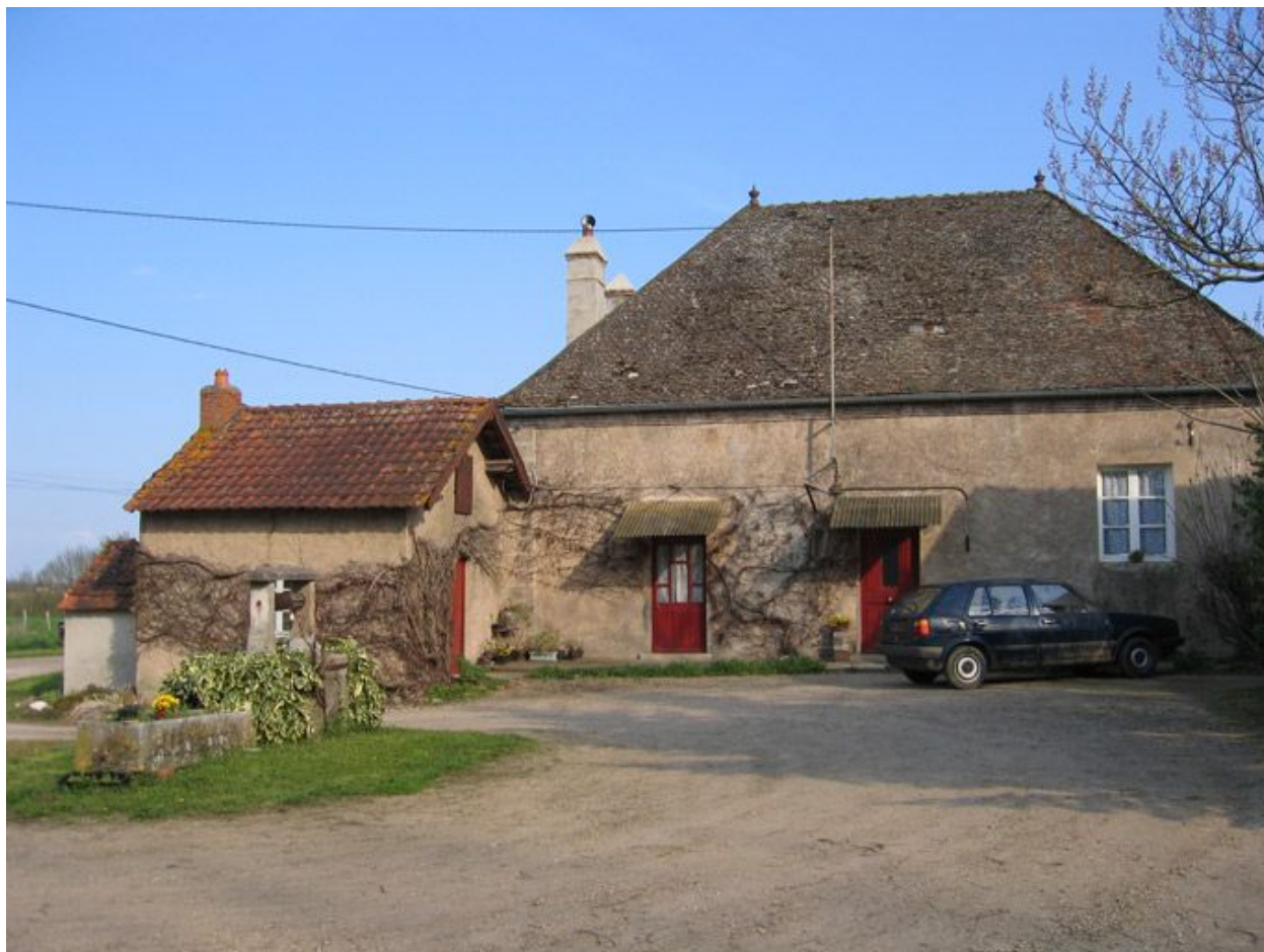
Vue d'ensemble de la façade de l'habitation.
