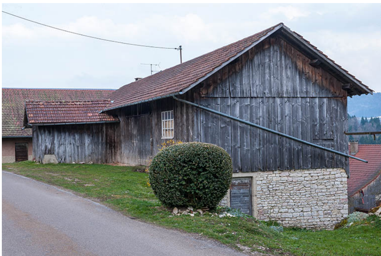
Bâtiment de la scie.
