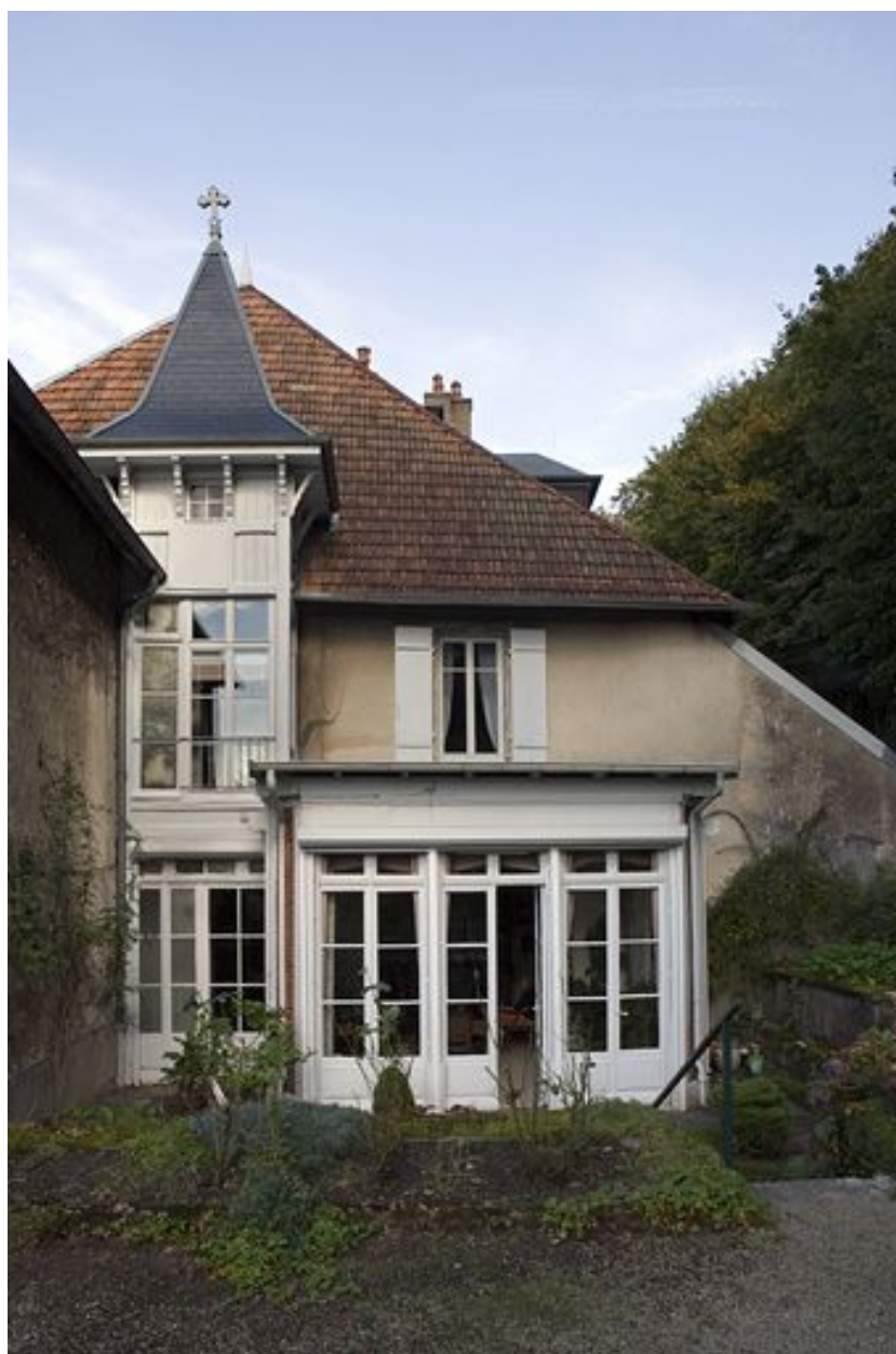
Façade latérale droite : vue rapprochée de face.
