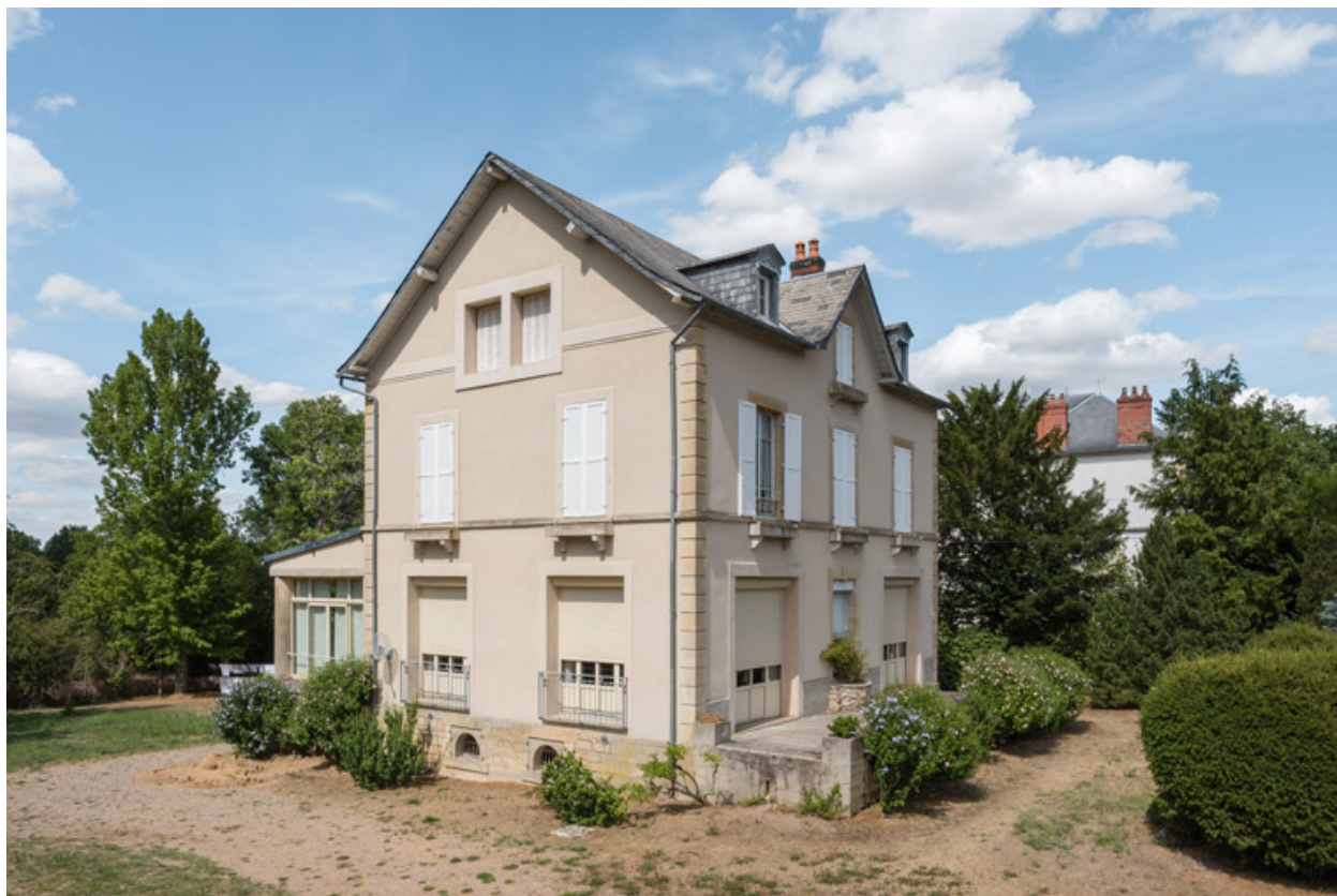
Vue depuis le sud.
