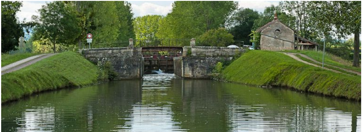
Vue du pont depuis l'aval.
