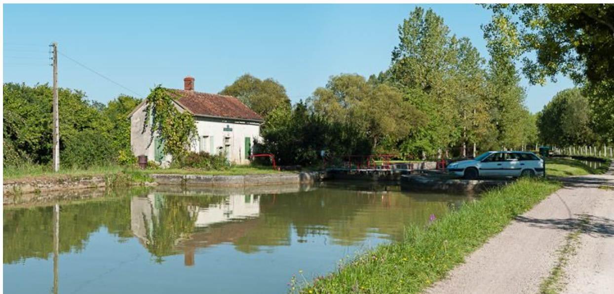
Vue du site d'écluse depuis l'amont.
