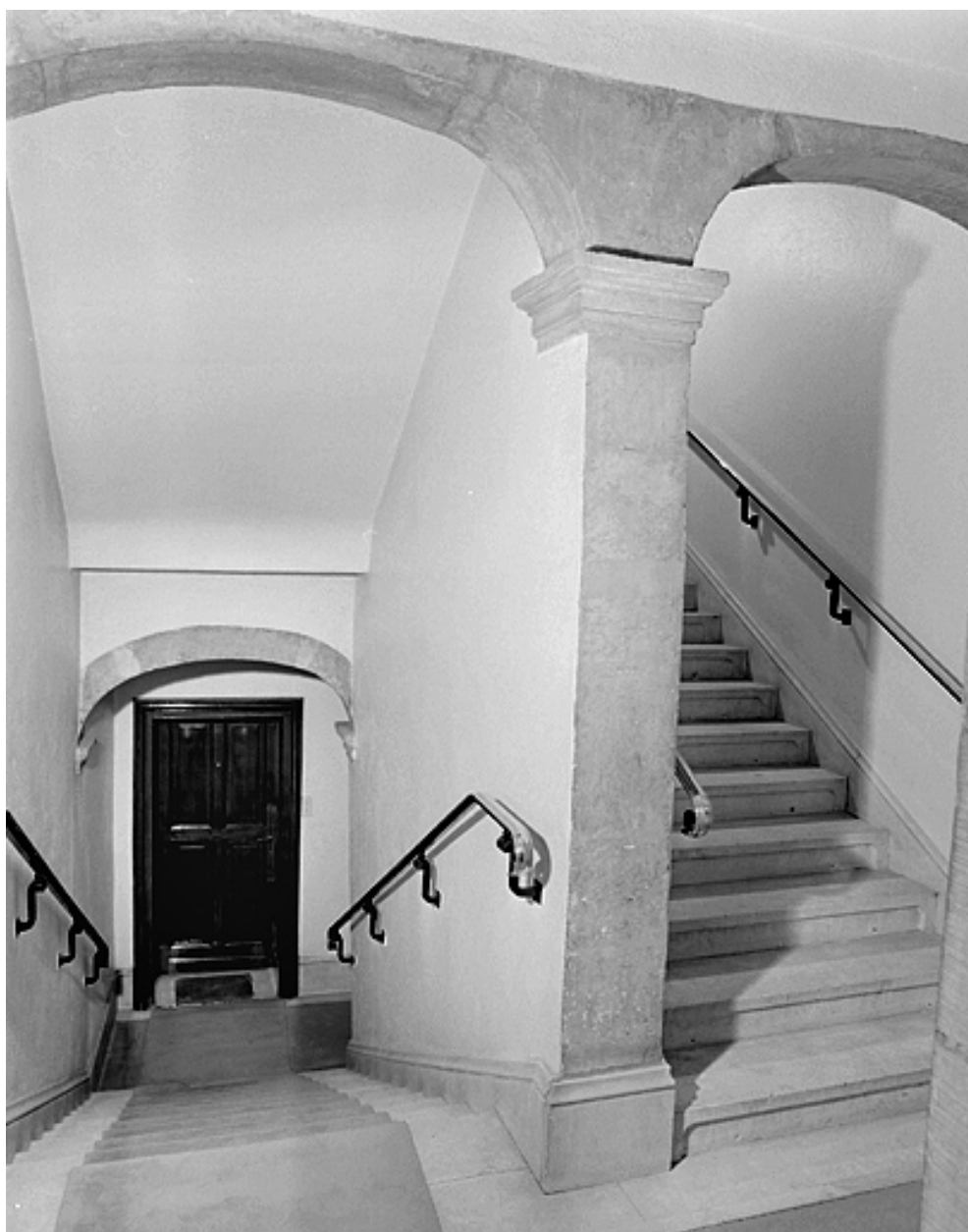
Escalier vu du palier du deuxième étage.
