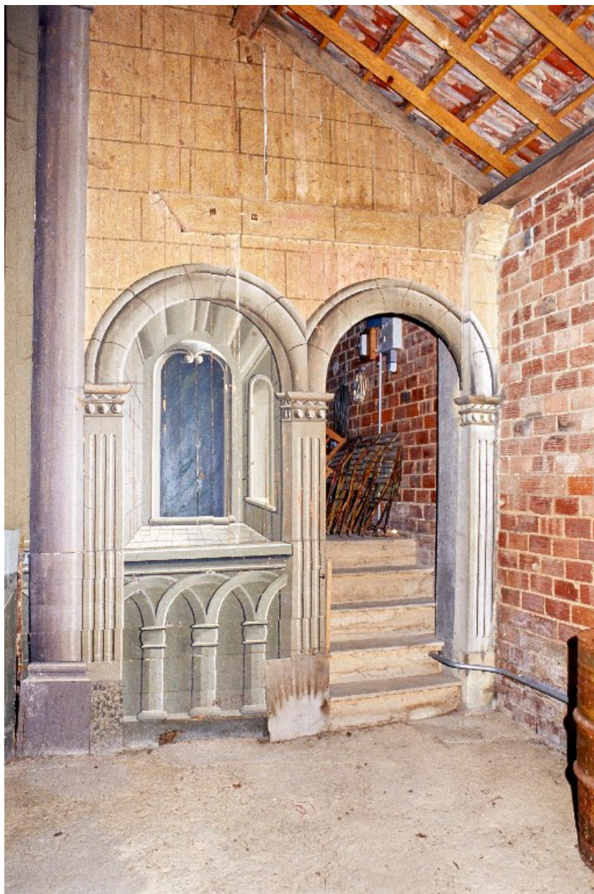
Baie côté cour, en 2002.
