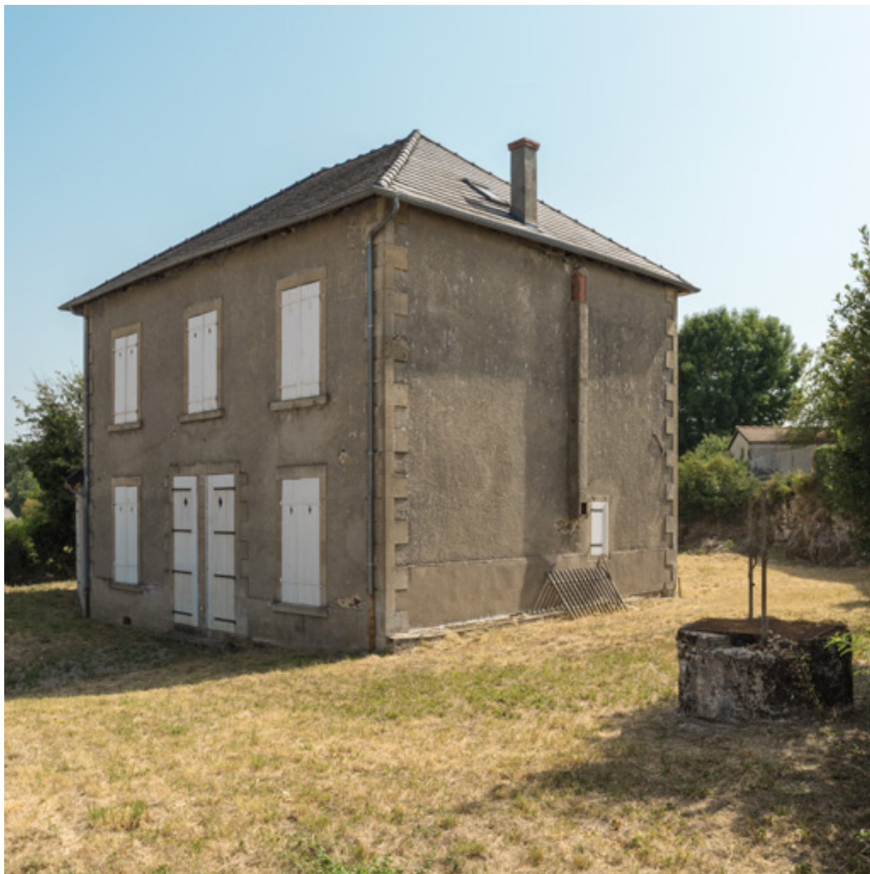
Façade principale, vue depuis le sud-ouest.
