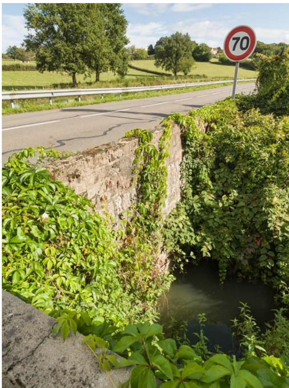
Vue de l'aqueduc.
