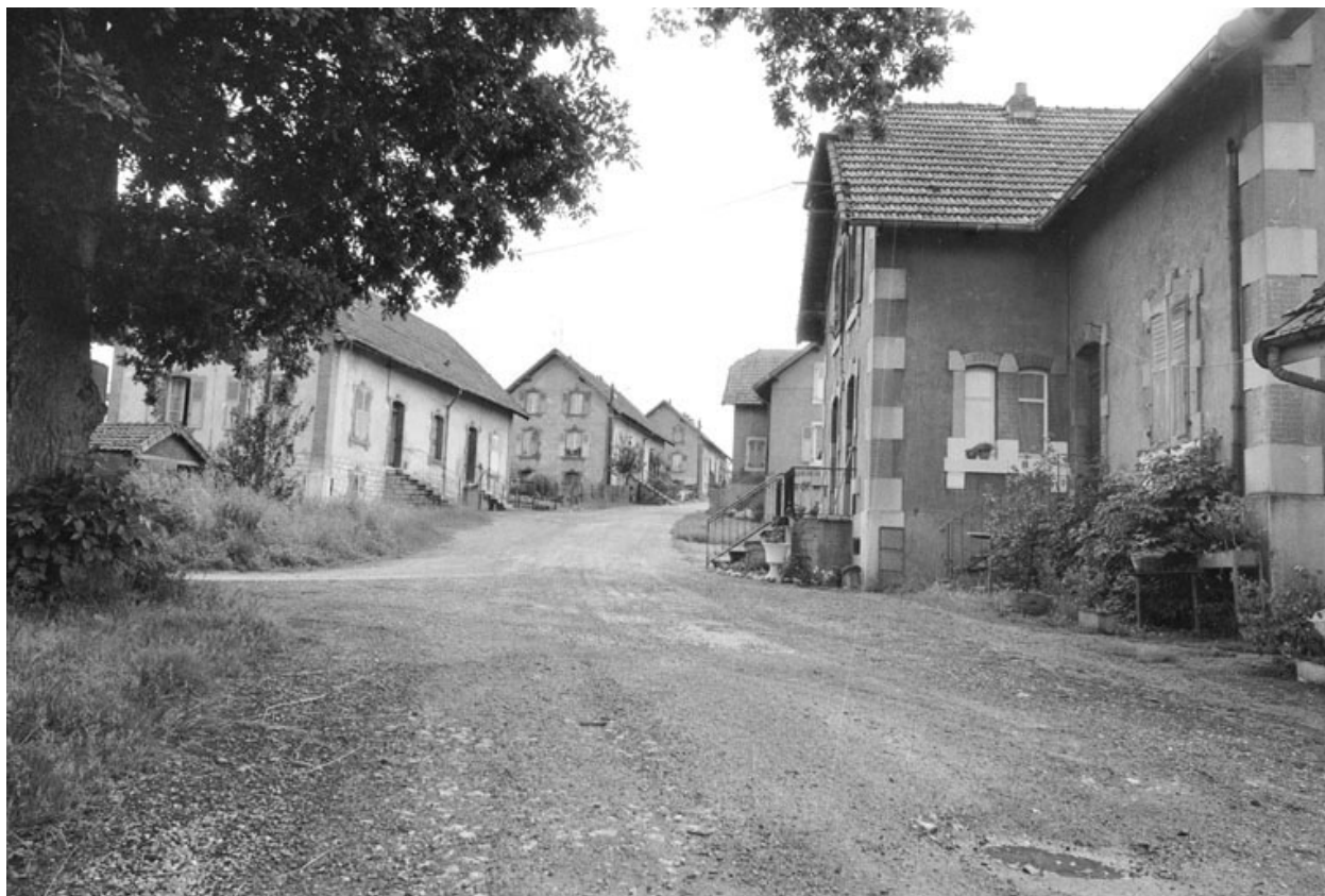
Cité ouvrière en 1980.SRI. Enquête régionale sur les bâtiments industriels (1979-1981).
