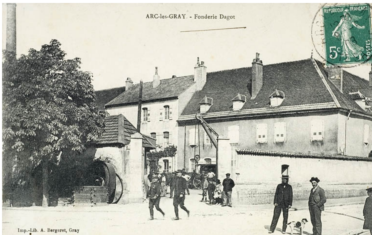
Arc-lès-Gray. - Fonderie Dagot.
