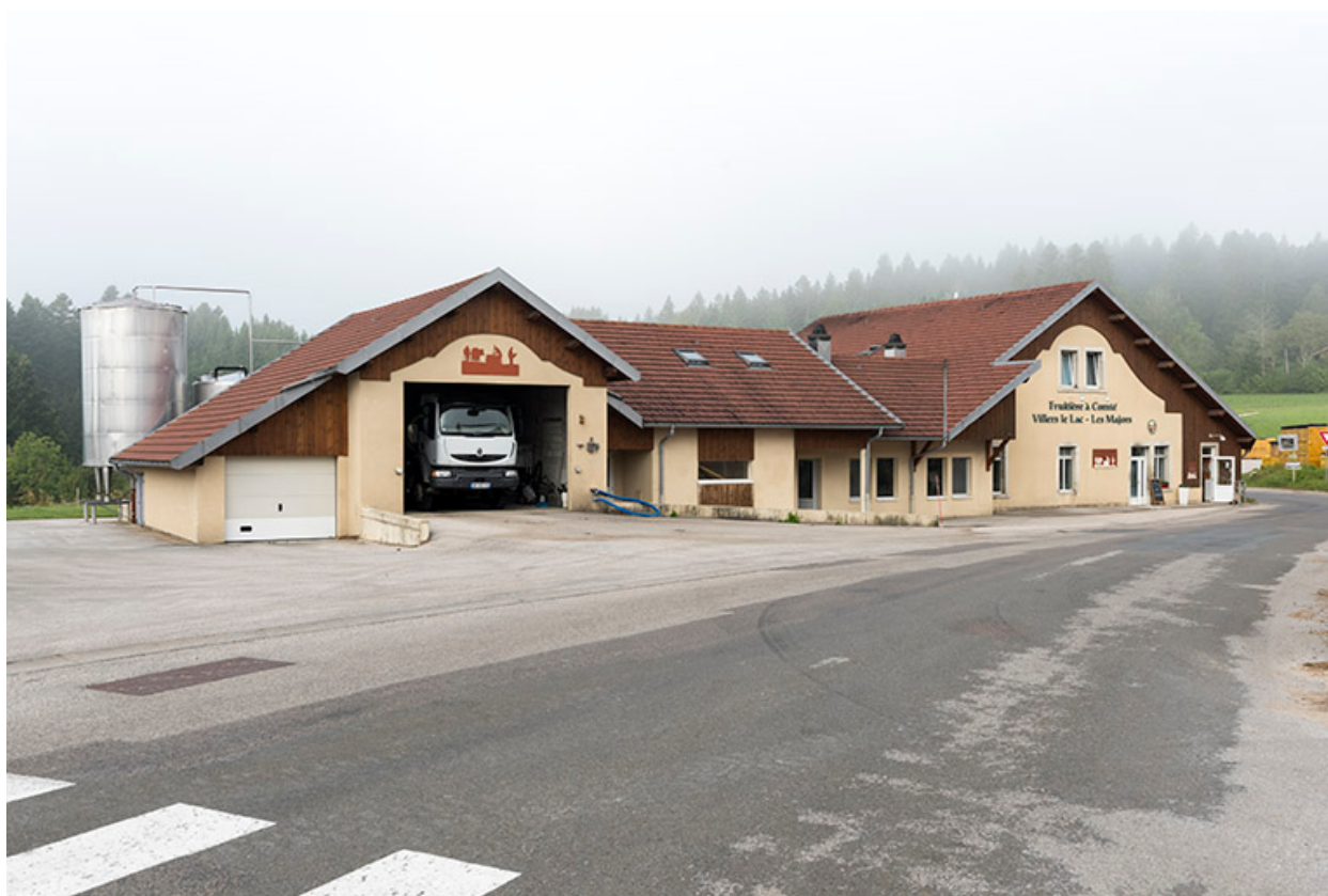
Vue d'ensemble, depuis l'est (façade antérieure).
