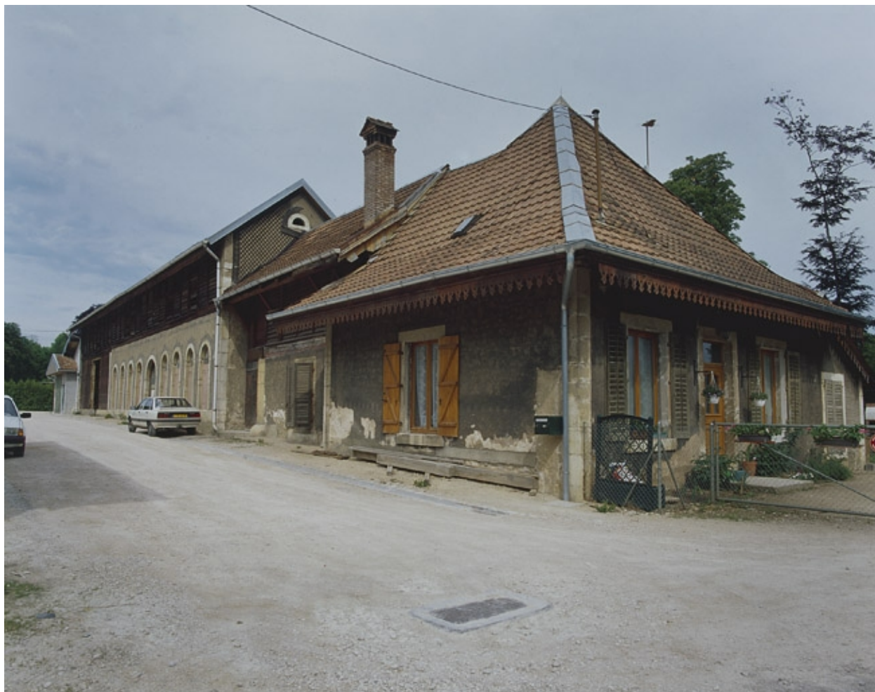
Orangerie et logement depuis l'est.
