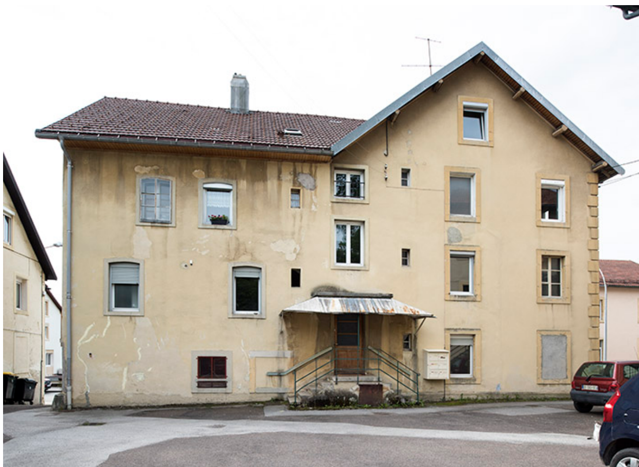
Bâtiment sur rue : façade postérieure.
