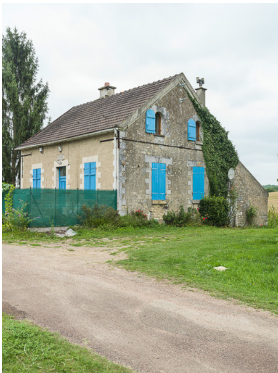
Vue de la maison éclusière.
