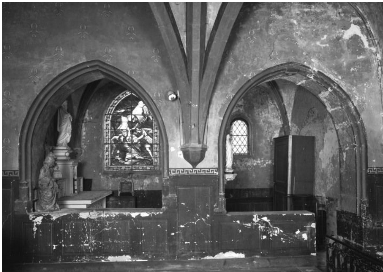
Chapelle latérale, vue depuis le chœur
