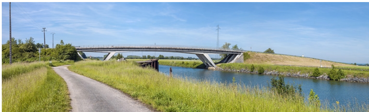
Vue d'ensemble d'amont, rive gauche.
