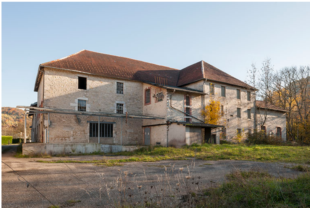
Atelier de fabrication vu depuis le nord.
