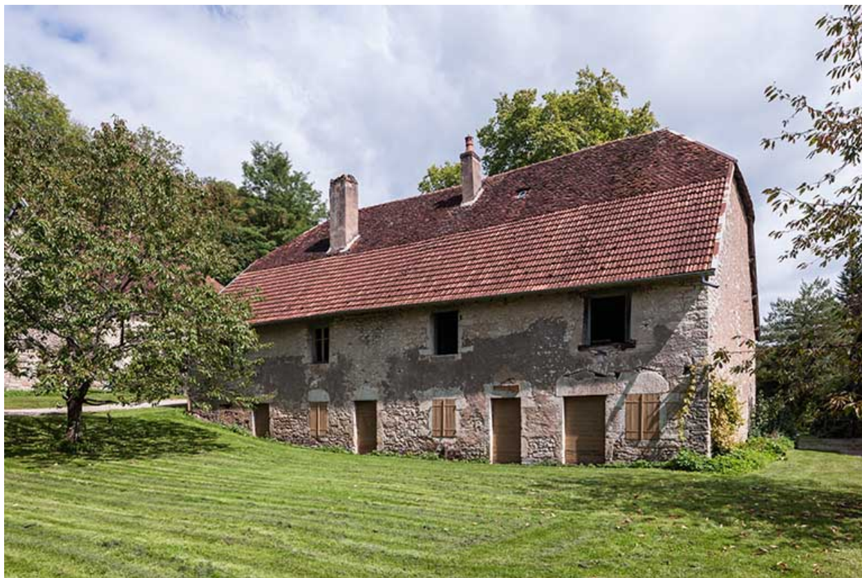
Logement d'ouvriers. Façade ouest de trois quarts.
