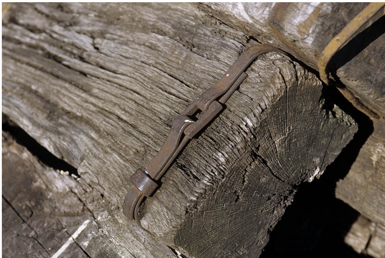
Extrémité d'une traverse avec frettage Delor.
