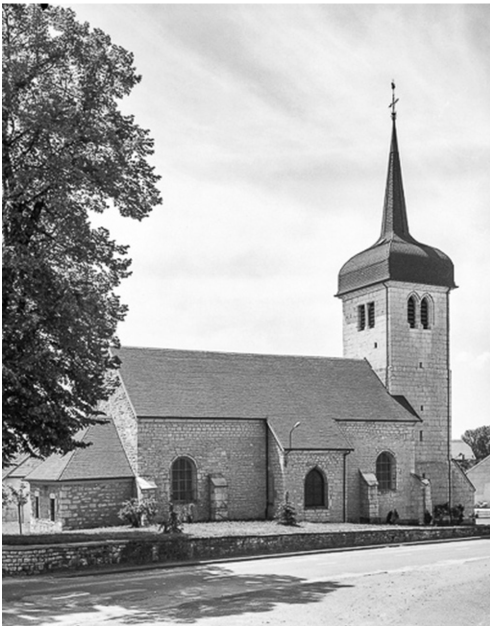
Extérieur : façade latérale gauche.
