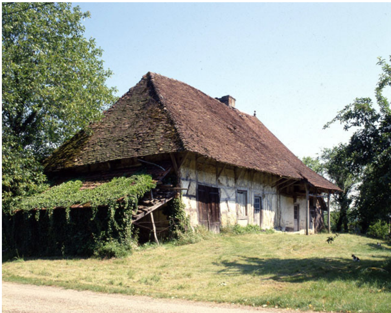
Cosges : ferme située rue du Moulin de Jousseau.
