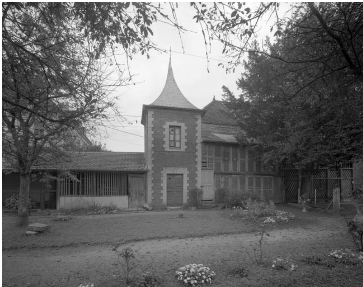
Bûchers et pigeonnier à droite de l'arrière-cour.
