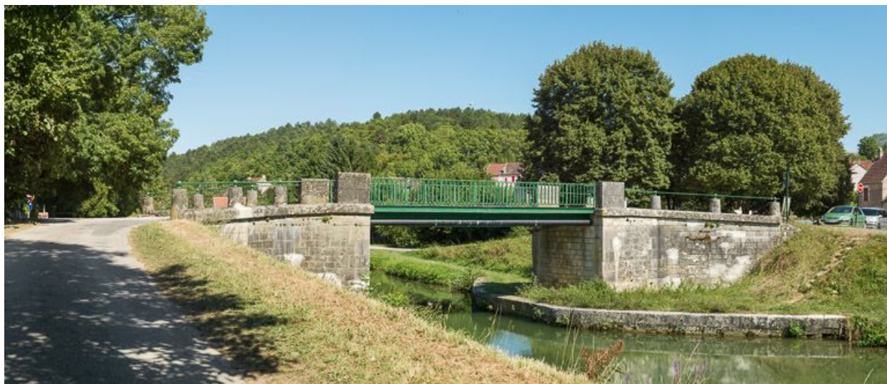
Vue d'amont du pont.
