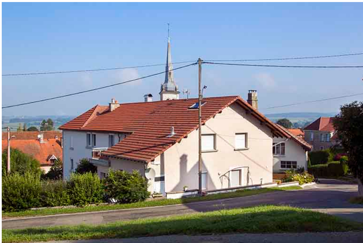
Façades postérieure et latérale droite.
