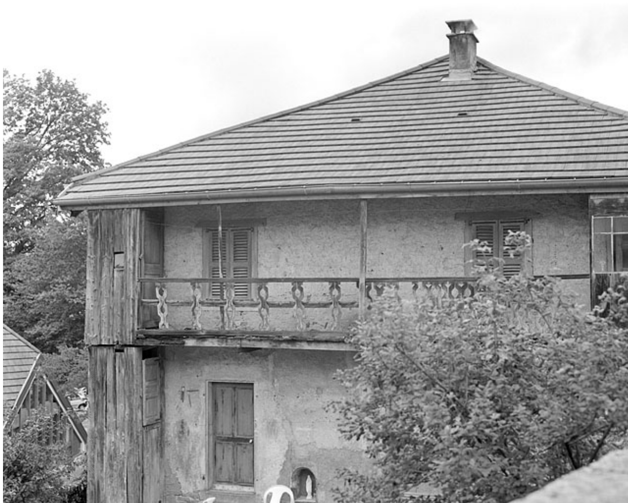
Balcon en galerie sur la façade antérieure.
