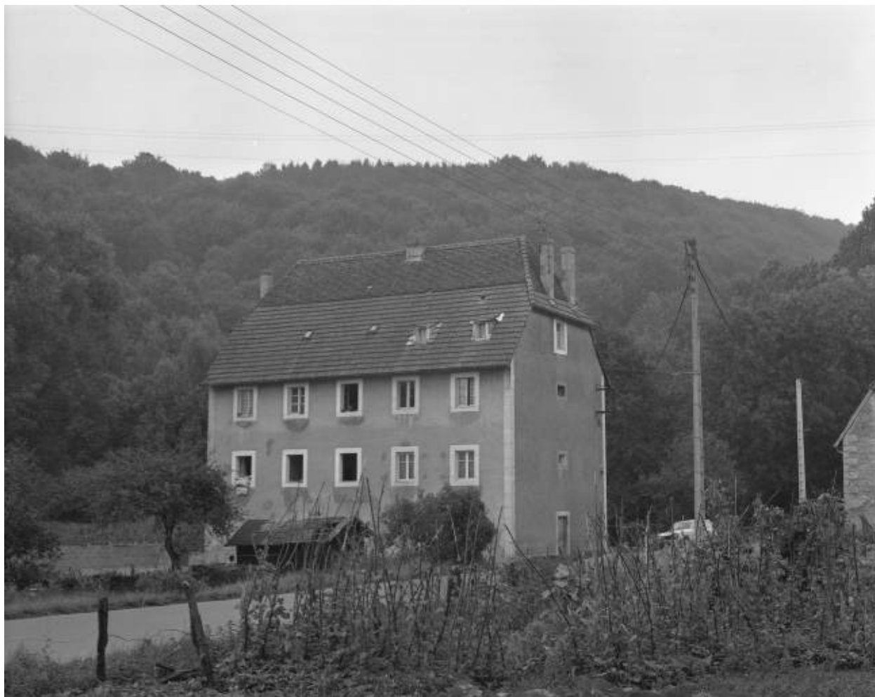
Logement ouvrier vu de trois quarts en 1981.
