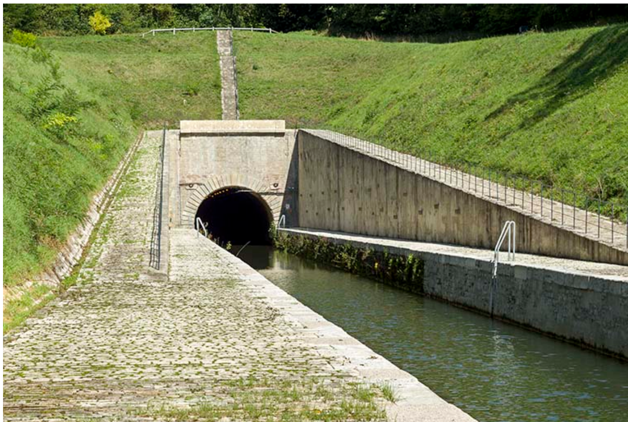
Entrée aval depuis le chemin de halage.
