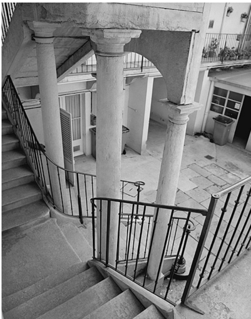
Maison, 74 rue Saint-Désiré, escalier sur cour, détail.
