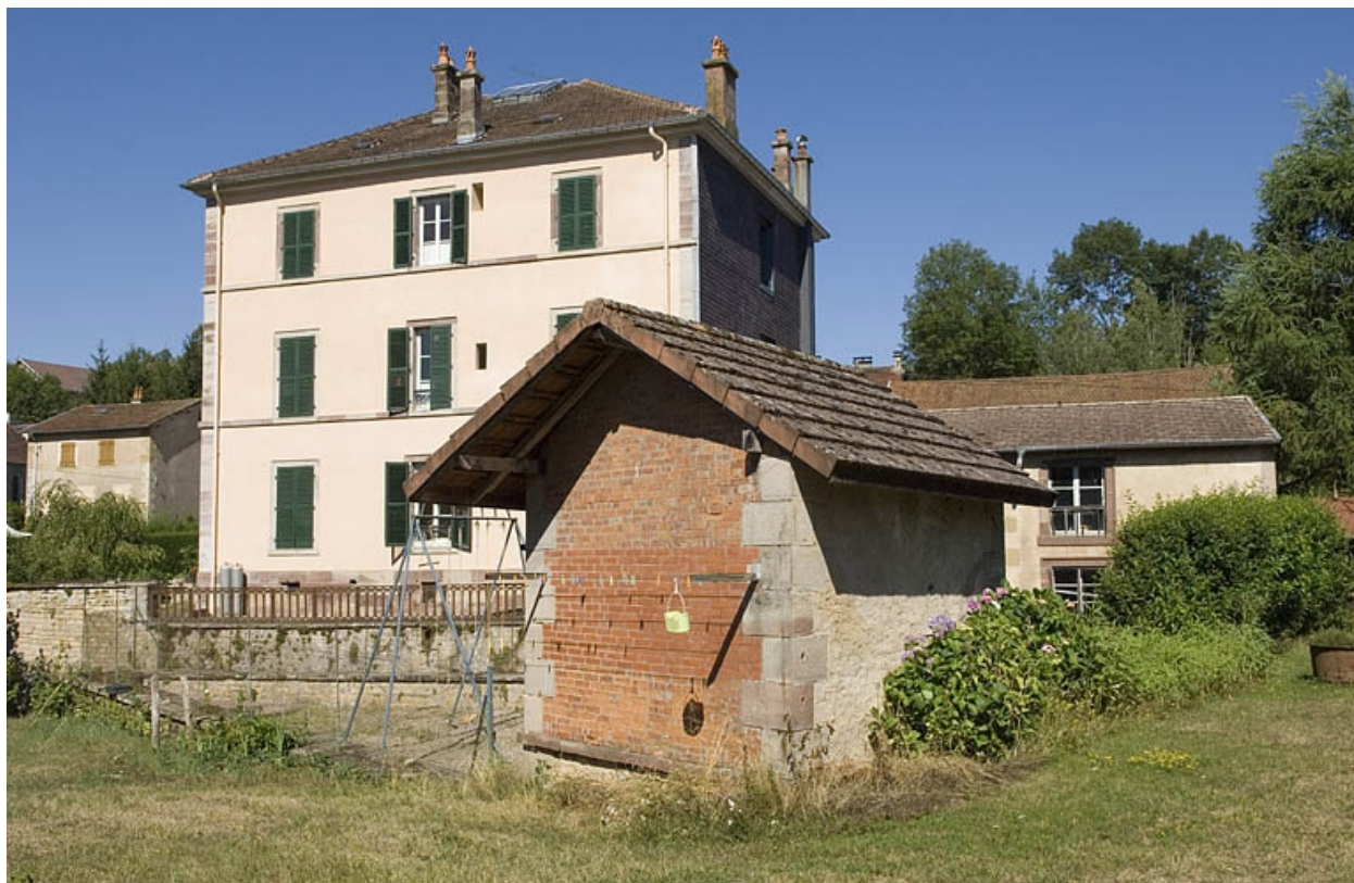
Logement patronal sud. Façade postérieure.
