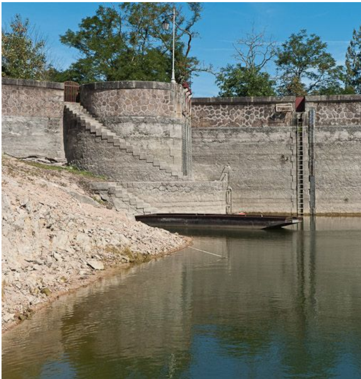
Vue de la tour de prise d'eau.
