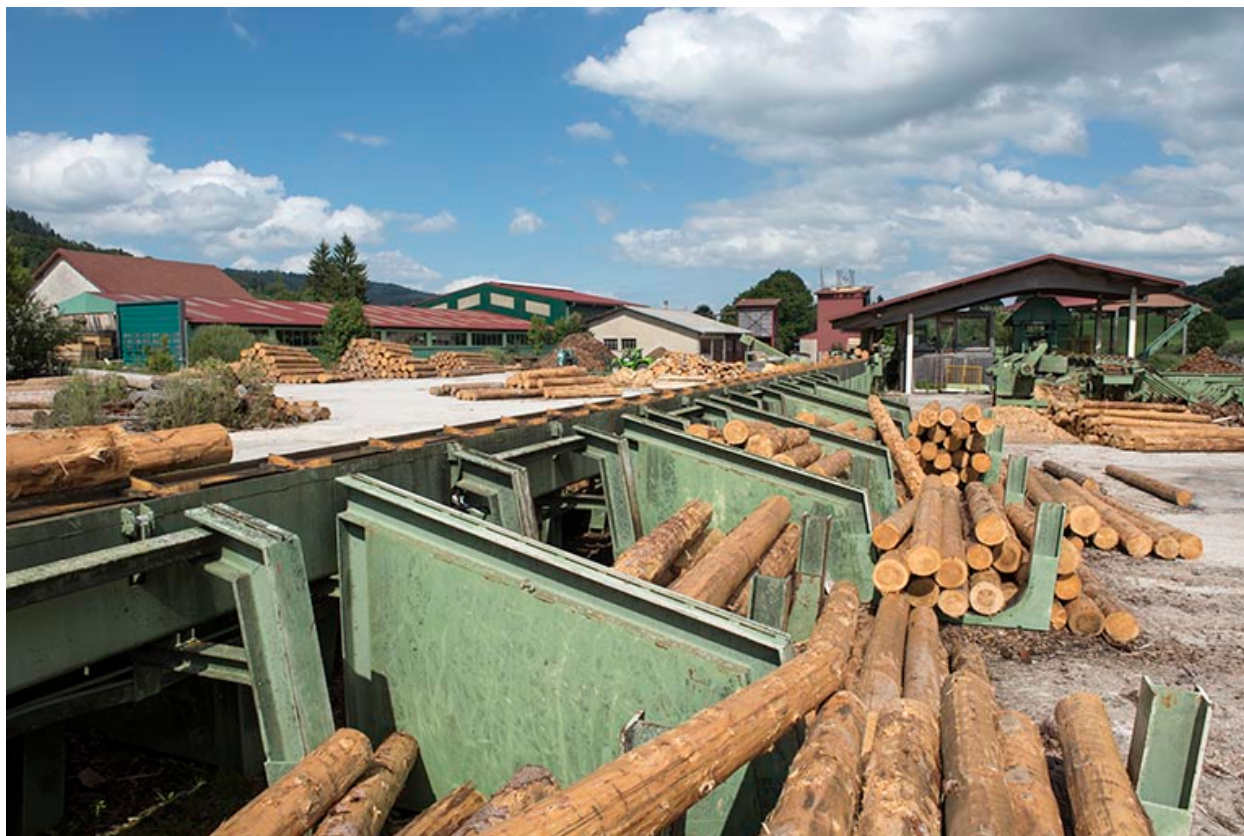
Scierie Boillot : vue partielle des installations.
