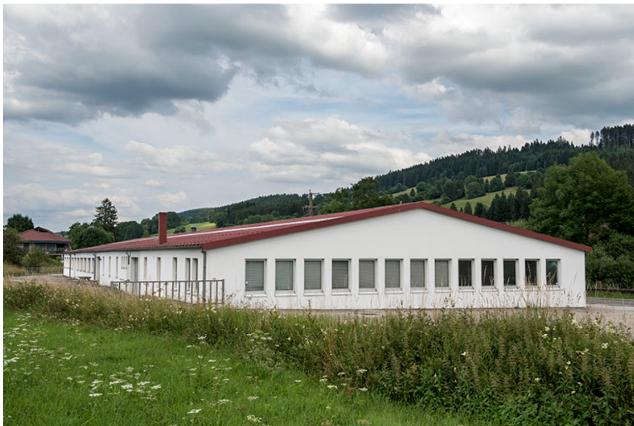
Façades postérieure et latérale gauche.
